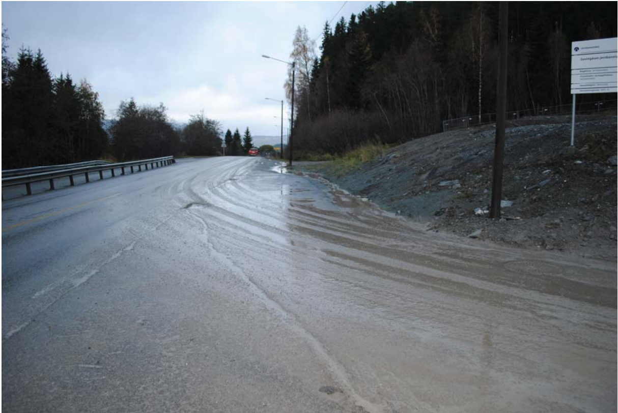
FV 950 før asfaltering
