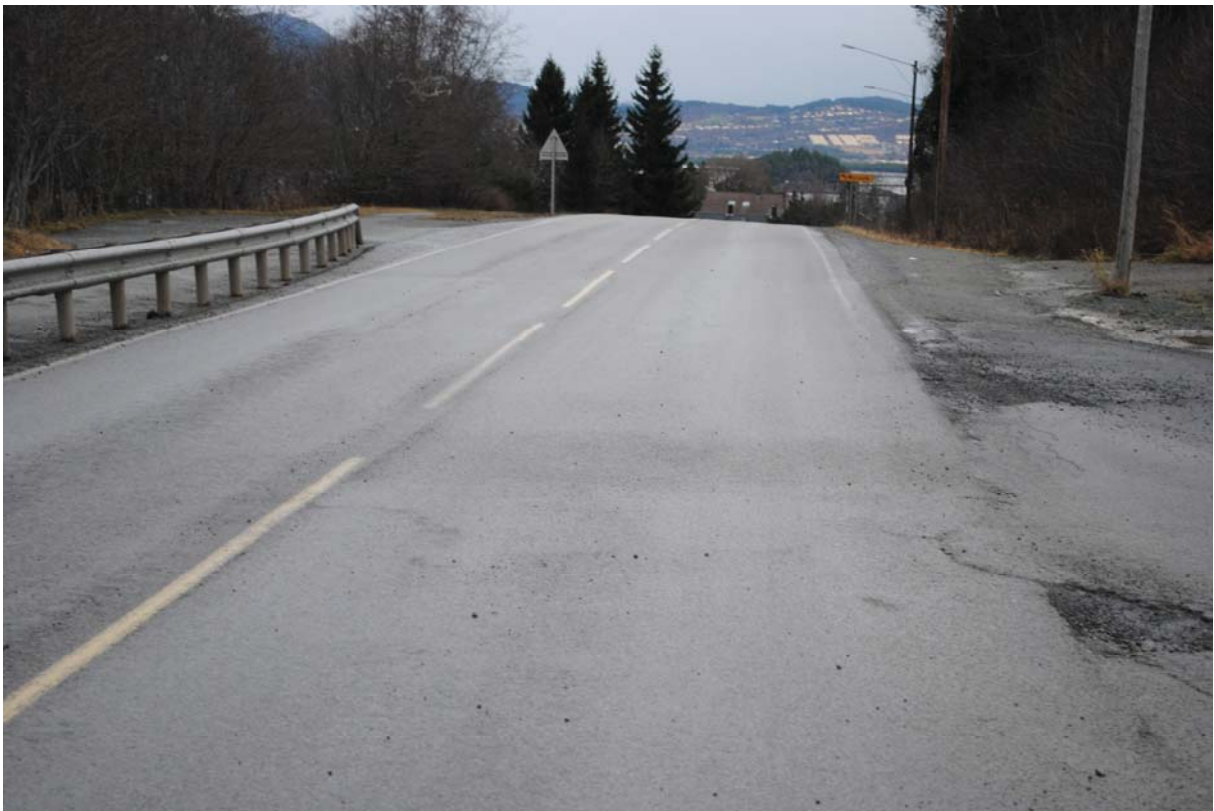
FV950 etter asfaltering
