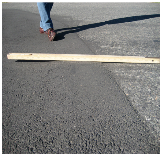
Figur: Nivåsprang mellom, nytt og gammelt dekke
