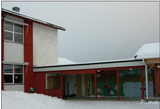
Mellombygg skal rives og erstattes med ny hovedinngang for skole.
