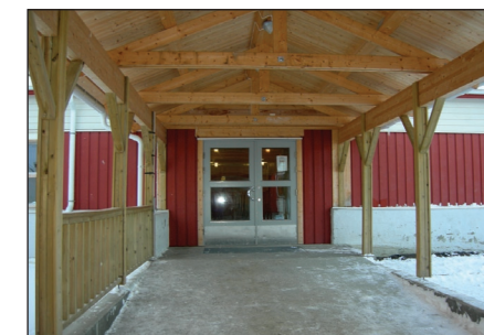
Inngang mot nord, -mot 64-bygget.
