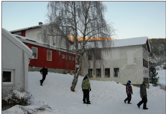
Mellombygg og østfløy skal rives og erstattes med nytt tilbygg.
