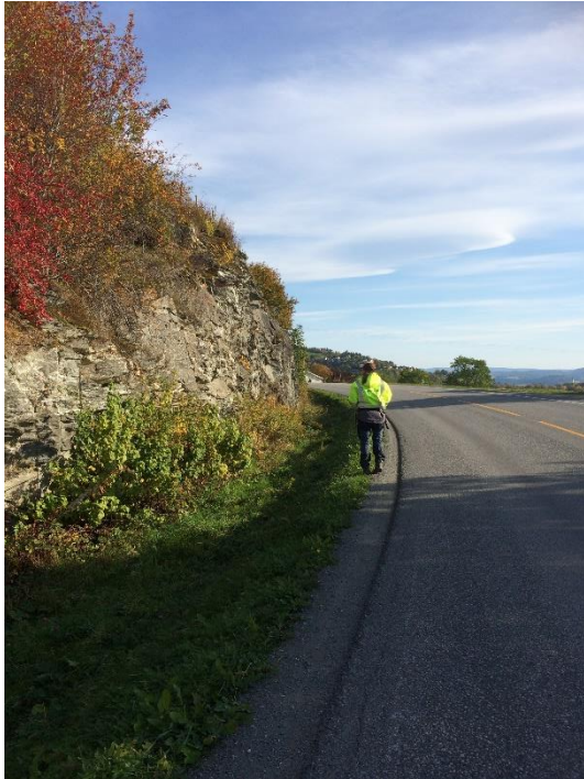
Figur 8 Skjæringer langs fv. 755
