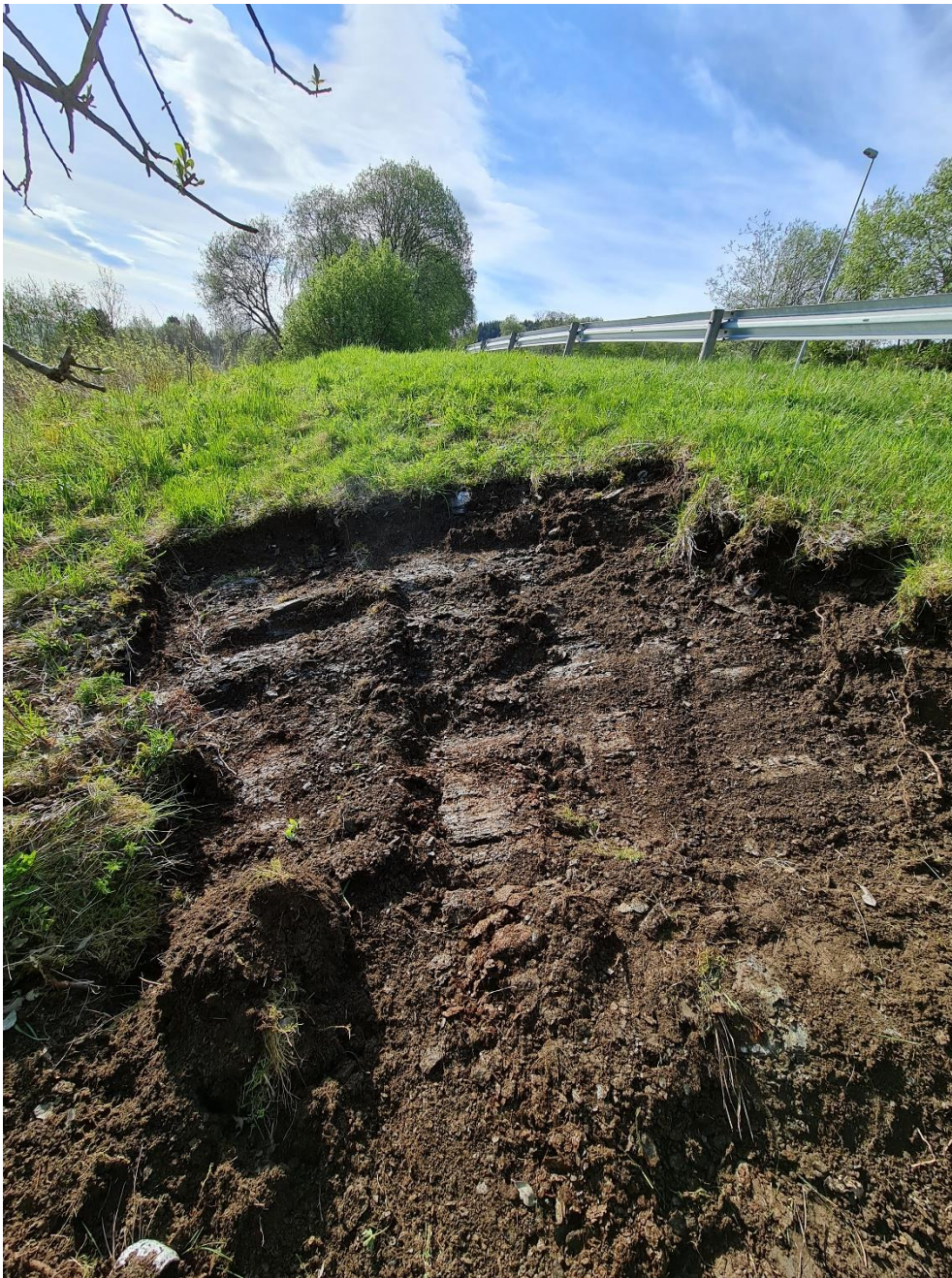
> Foto 6: Berg under tynt løsmassedekke 4
