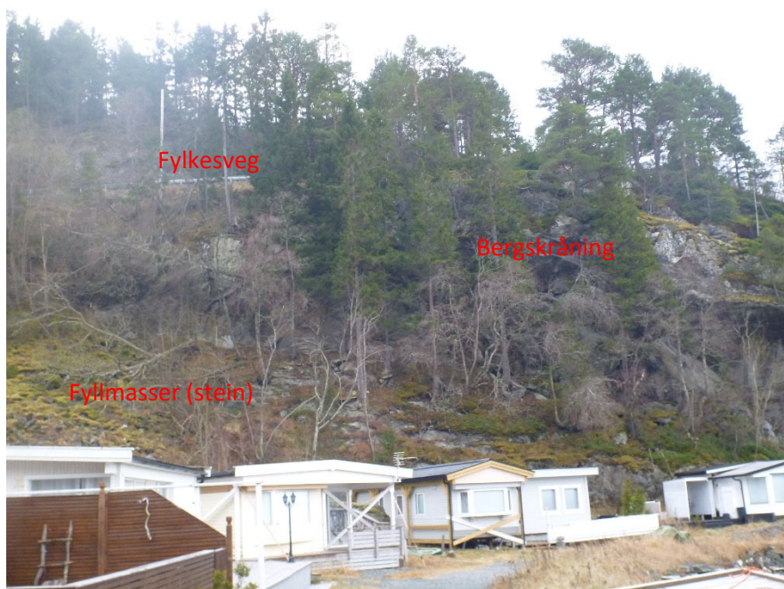
Foto 2: Sørvestre del av campingplassen. Fyllmasser og bratt skråning opp mot fylkesvegen.
