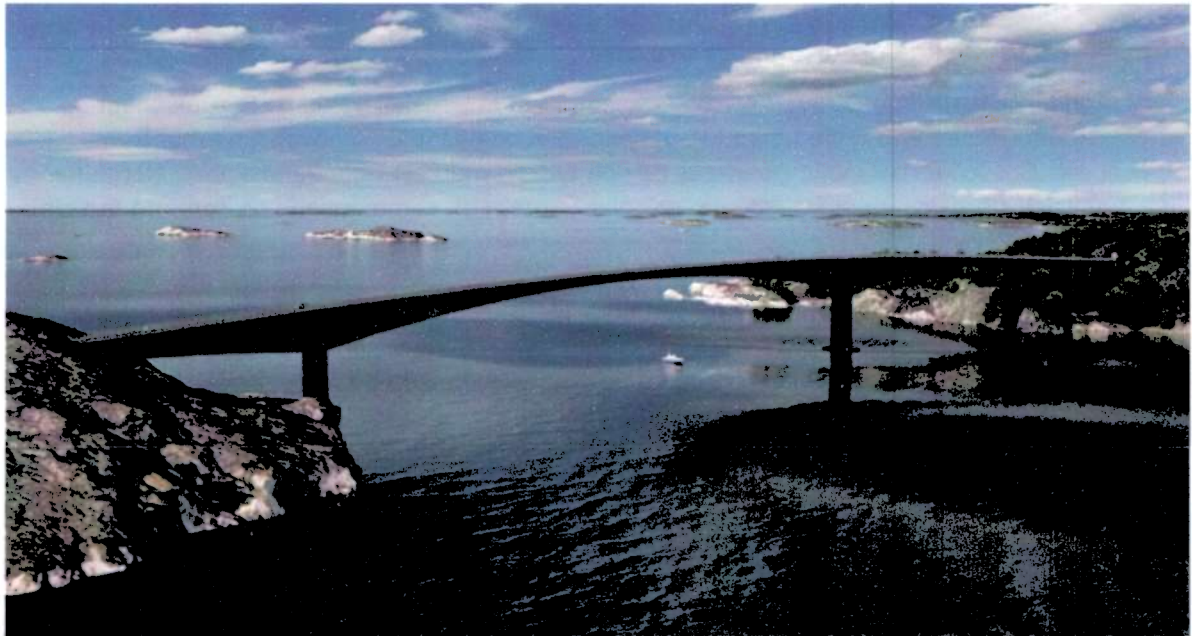
Figur 36 Fritt frambyggbru i Bollholmsundet
