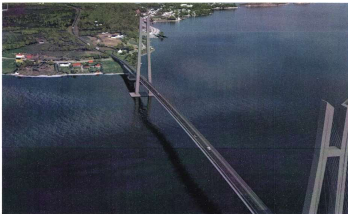
Figur 38 Alternativ skråkabelbru i Kjerringsundet
