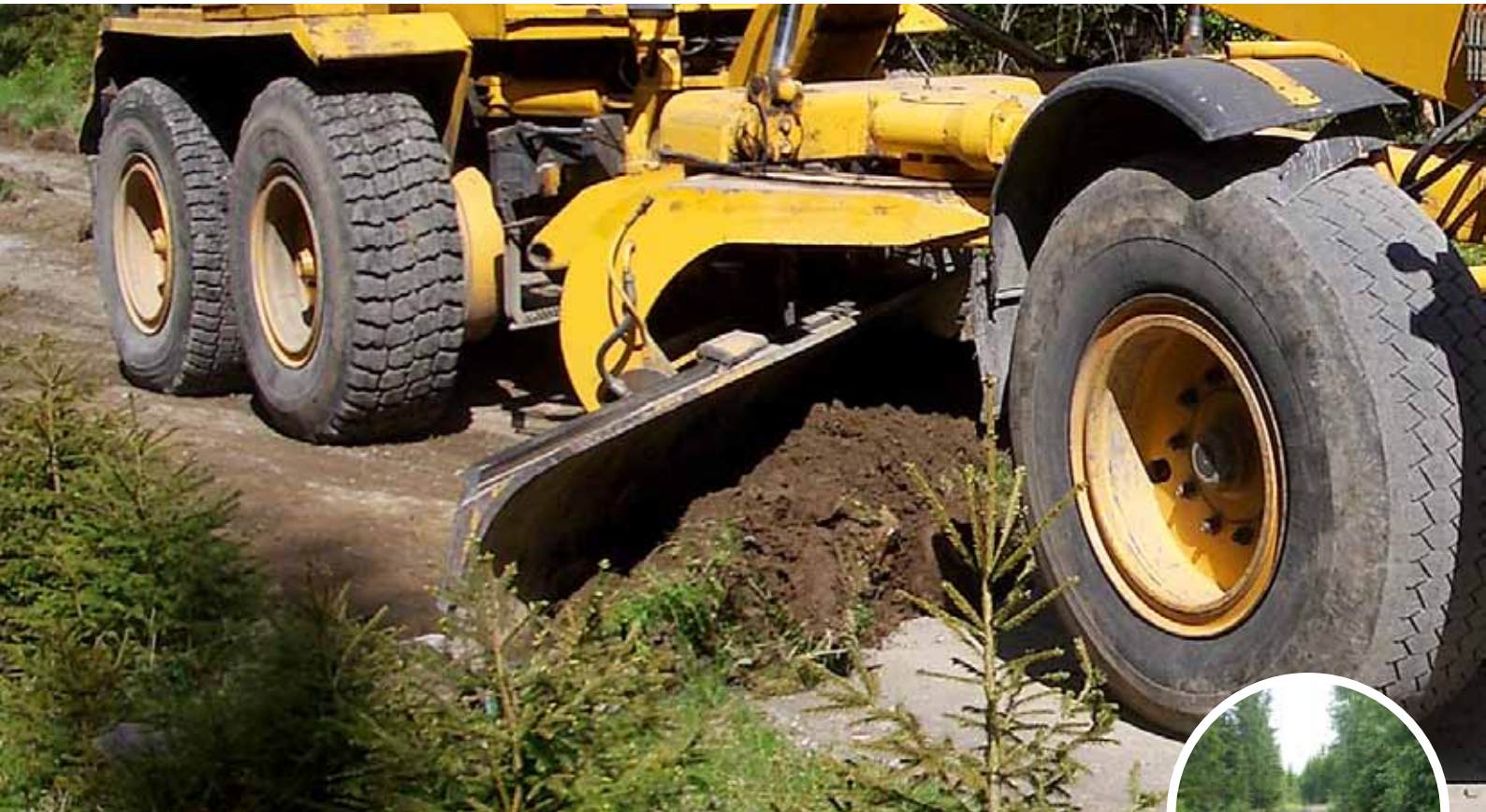
SLIK SKAL DET GJØRES! Høvling av skogsbilvegen bør skje hvert 5. år. FOTO: JON BRAASTAD
