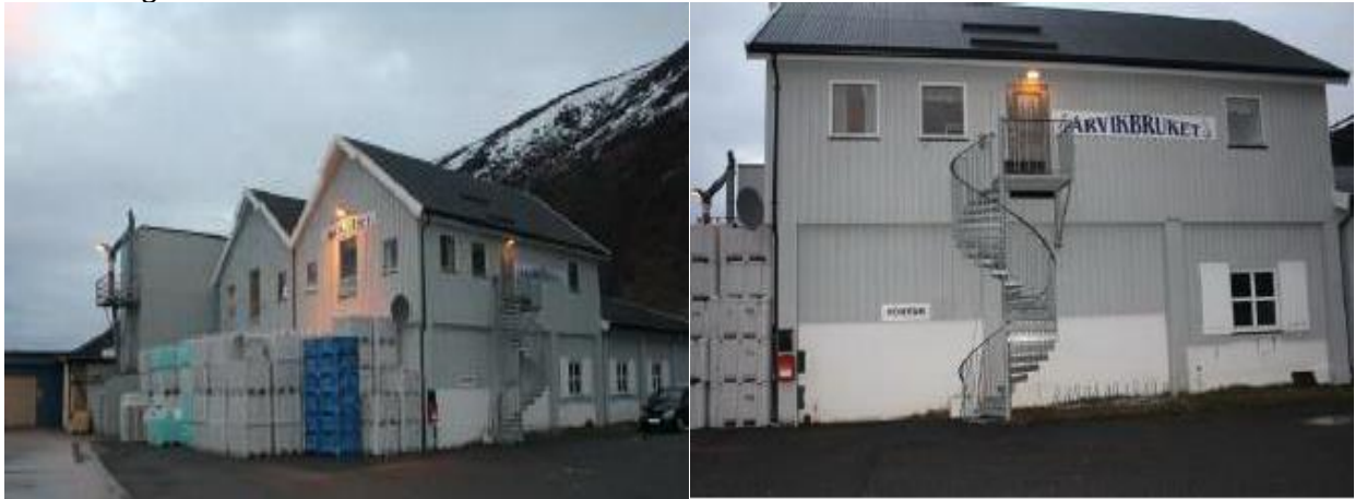
Foto: Byggebistand Troms
