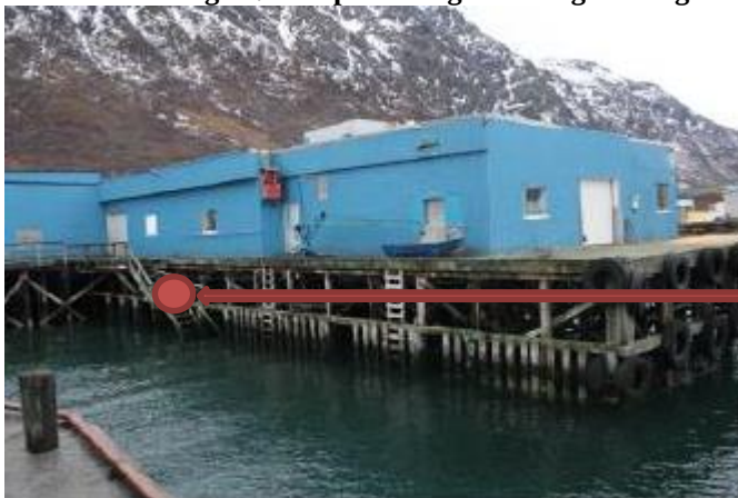
Bilde 8. Takstingeniørens plassering ved fotografering av bildene 5 og 6
