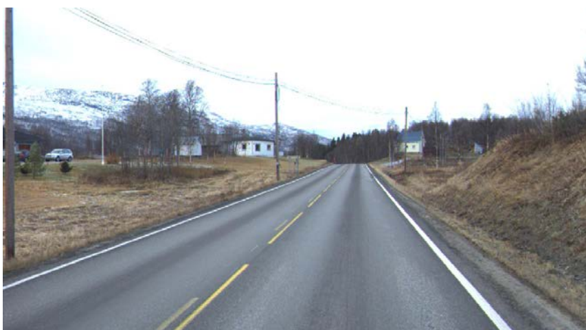
Fig. 5 lavspenst og høyspent går i luftstrek
