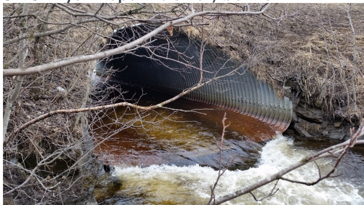
Fig 15 viser Olderbekken og røret som skal byttes ut med ny bru.
