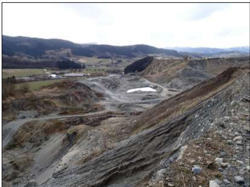
Figur 2. Oppe: Nordre del av masseuttaket, med et lite sedimenteringsbasseng nederst i denne delen av masseuttaket. Nede: Søndre del av masseuttaket til Etne Sand & Pukk, sedimenteringsbasseng på lavestliggende del, midt i uttaksområde.
