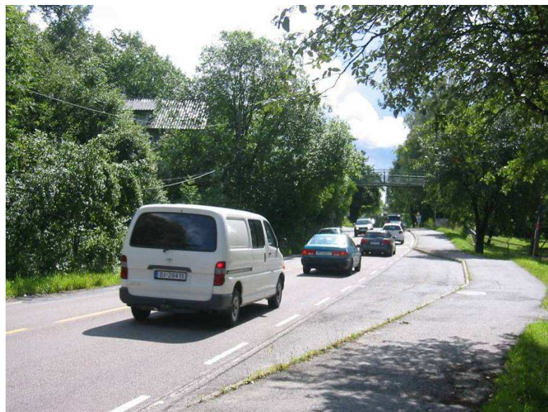
Figur 6-1: R v 152 Skiveien ved Greverud skole. Strekningen er med i miljøplanen for Rv/Fv 152 Punkttiltak langs Fv 152
