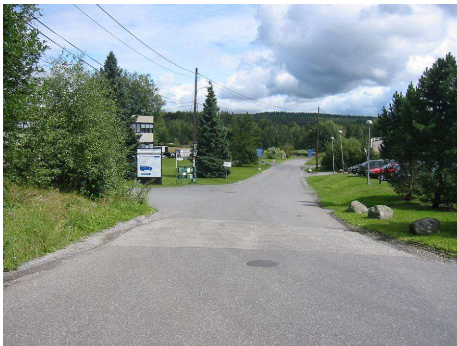
Figur 5-2: Forlengelse av gang- og sykkelveg langs Fløisbonnveien er et av tiltakene i planen (tiltak E).
