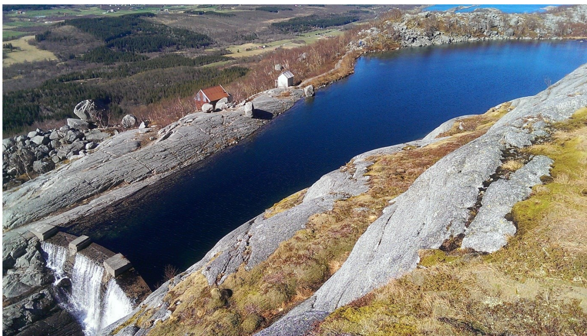
FJELLSÅSDEMNINGEN, DEL AV DEN TIDLIGERE VANNFORSYNINGEN TIL SANDNESSJØEN. FOTOGRAF: TROND BARGEL.
