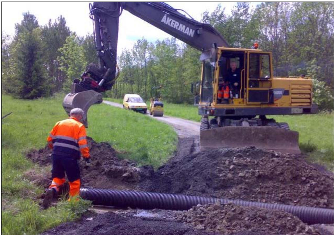
Bilde 3: Utbedring av Solbråtanveien.
