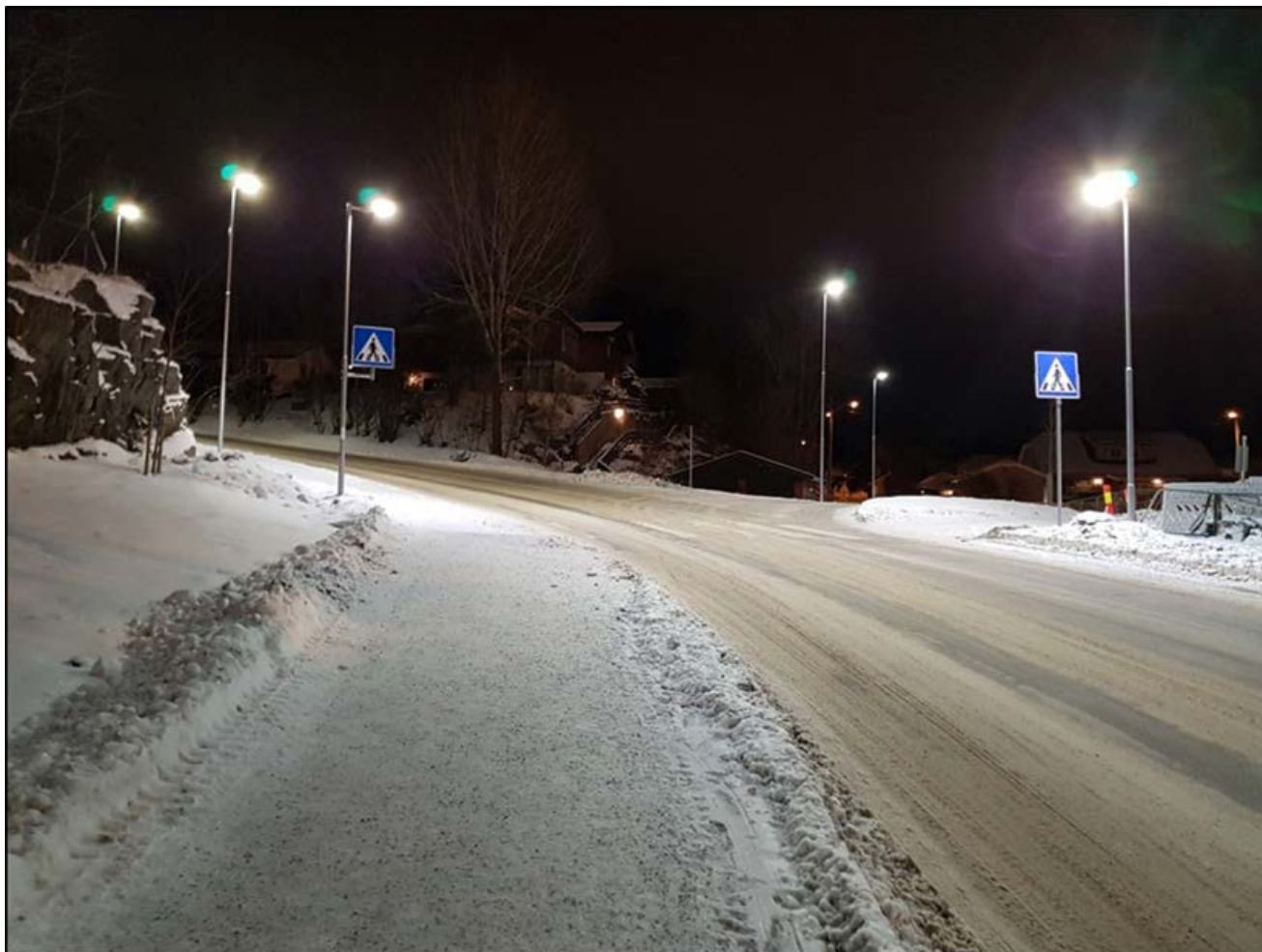
Bilde 1: Bildet viser nye lysstolper med LED-armatur ved krysset Ormerudveien/Fjellveien.
