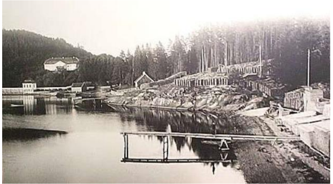
Figur 16 Driften ved Ljansbruket, sett inn mot Hvervenbukta. I bakkant kan man skimte den tidligere hovedgården til Stubljan. Kilde: Oppegårdeventyret.no
