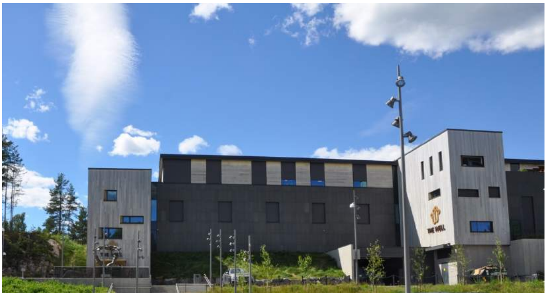
The Well – eksisterende spa-anlegg, sett fra øst.
