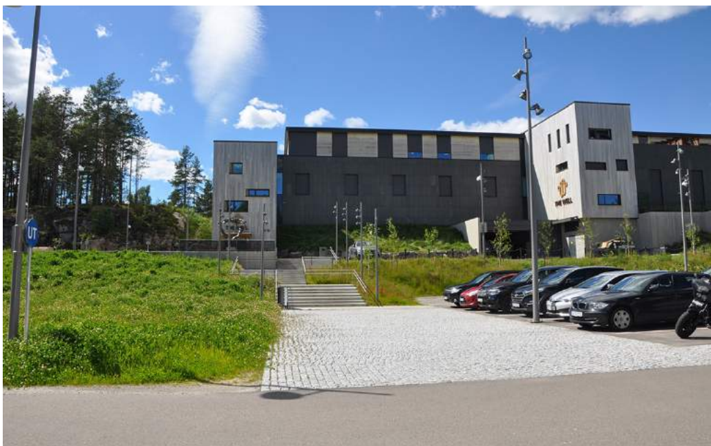
Bilde som viser dagens situasjon. Parkeringsplassene er etablert i lavbrekket hvor det tidligere var myr. Arealene er fylt opp med drenerende masser. Parkeringsanlegget vil utvides, til å få et lokk over.
