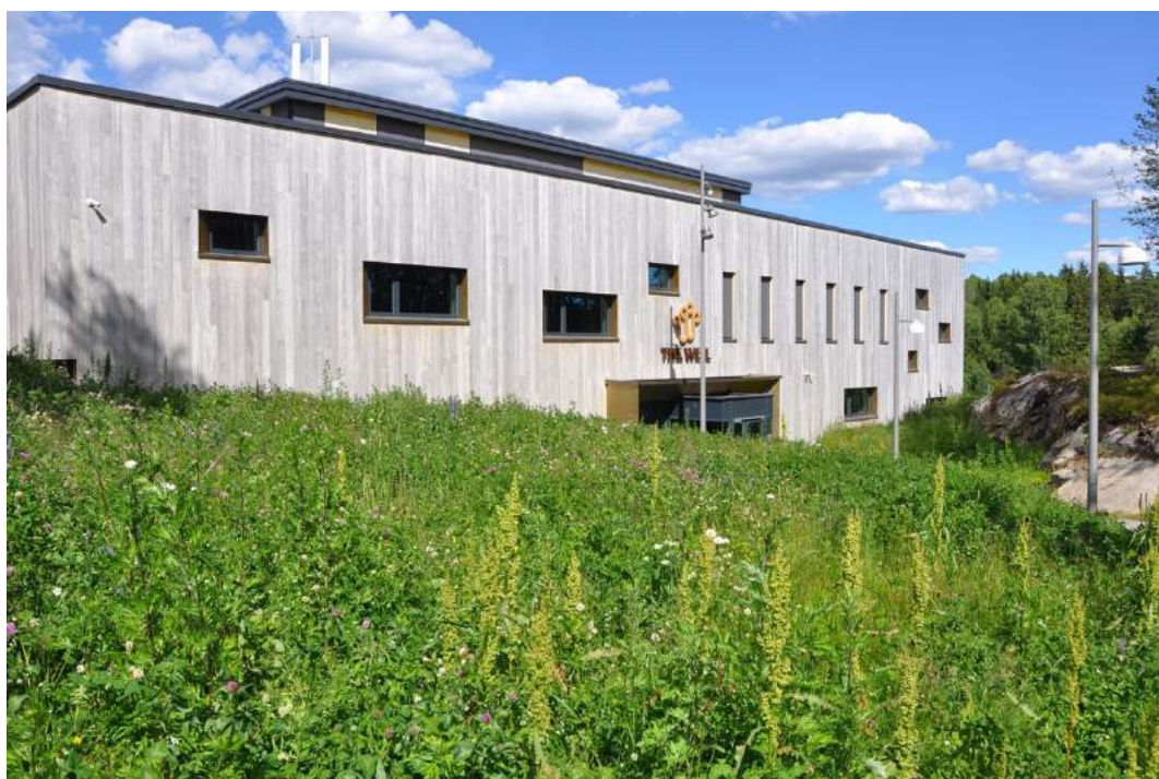
The Well sett fra turvegen som leder fra bussholdeplassen i Kongeveien og frem til adkomsten.
