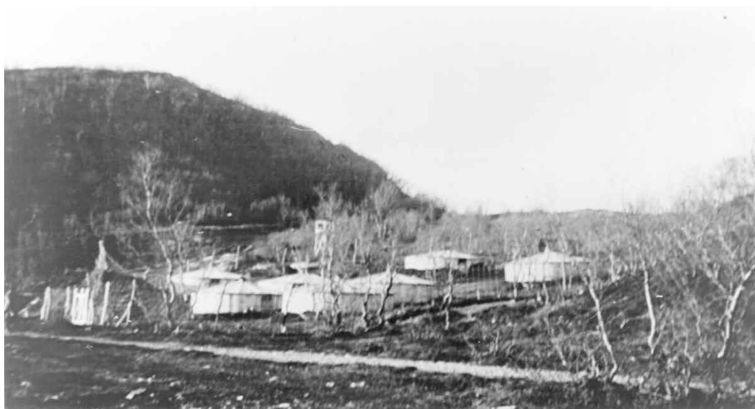
Gjennom fotografier og skriftlige kilder er det mulig å skaffe til veie mye informasjon om kulturminner som ikke nødvendigvis er veldig synlige i terrenget. På fotografiet over ser vi fangeleiren slik den så ut i 1943. Fangene levde under ekstreme forhold, med små rasjoner og i uisolerte finérhytter. Det er tuftene etter en av disse hyttene man kan se i dag. I bakgrunnen kan man skimte vaktårnet. Foto: NTRM
