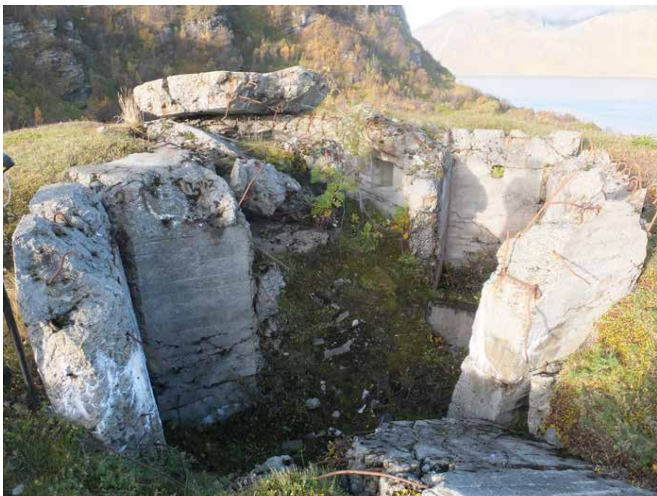
Restene etter en av to ringstænde på Engnes. Opprinnelig ville denne ha bestått av to deler, et rom for kanonen og et oppholdsrom for to soldater. Bunkeren har opprinnelig hatt tak med en sirkulær åpning for kanonen. Da tyskerne trakk seg tilbake fra Engnes i april 1945, ble alle våpen fjernet og stillingen ble sprengt.
