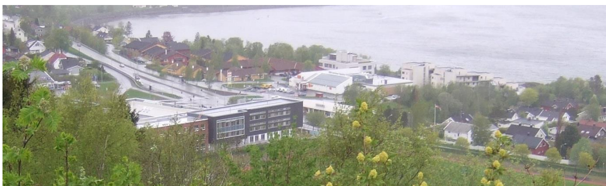
Figur 4: Oversiktsbilde som viser Vikhammer sentrums hovedtyngde. Til venstre i bildet kan Rema1000 ved lyskrysset skimtes. I forkant ses Malvik videregående skole, med fotballbane. Mot høyre, på nedsiden av Malvikvegen er Vikhammer senter, Vikhammer helsetun og TOBBs boligblokker (foto: Malvik kommune).
