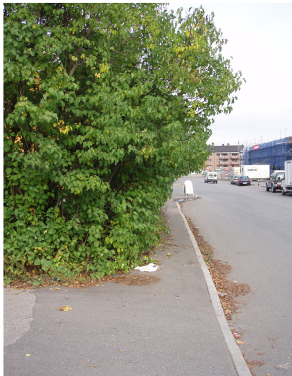
Figur: Manglende nedklipping av privat vegetasjon medfører sikt- og fremkommelighetsproblem
