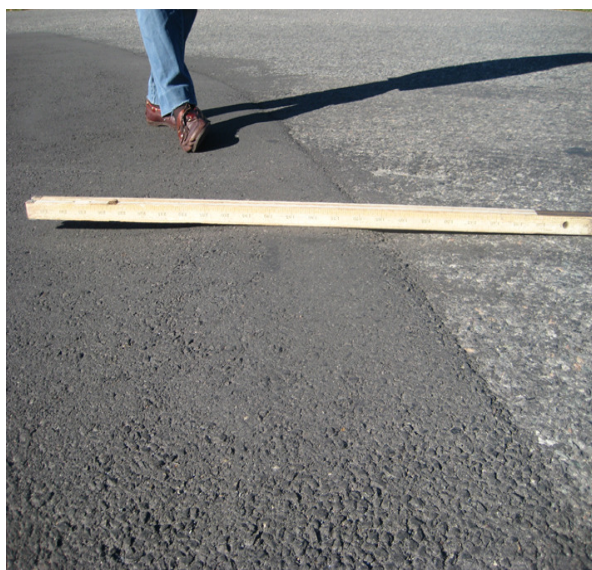
Figur: Nivåsprang mellom, nytt og gammelt dekke
