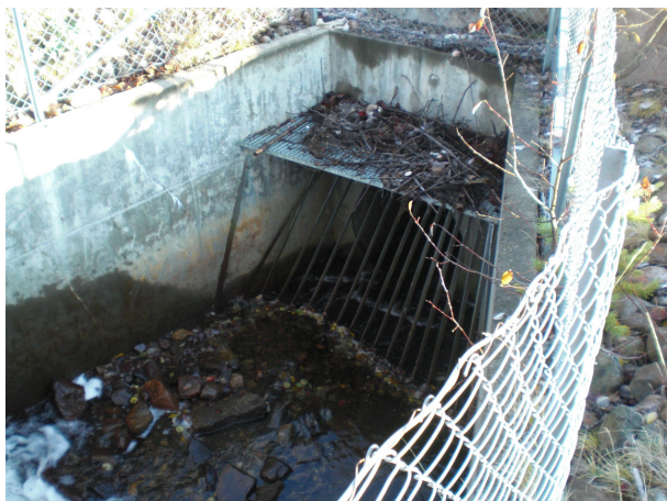
Figur: Bekkeinnslag med behov for rensk av innløp og rist.
