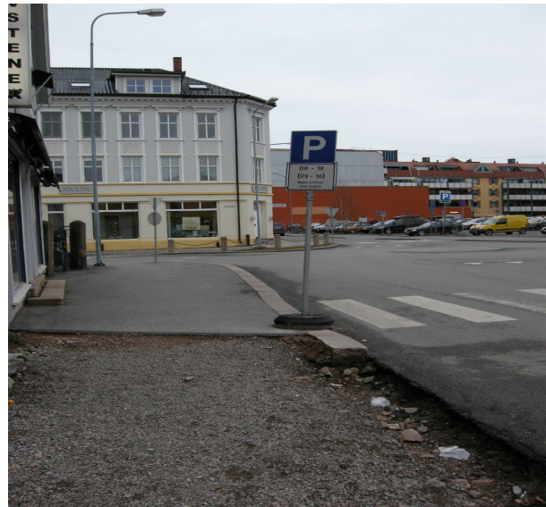
Figur: Manglende avsperring av arbeidssted.
