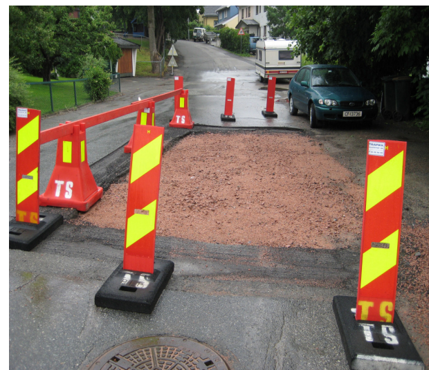
Figur: Sikring av gravested
