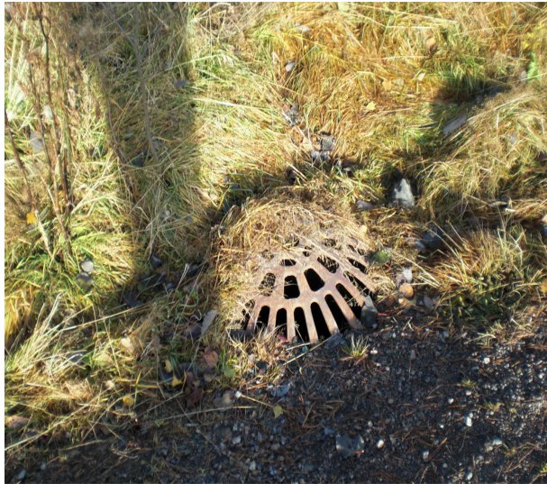
Figur: Manglende rensk rundt kuppelrist reduserer ristens kapasitet.
