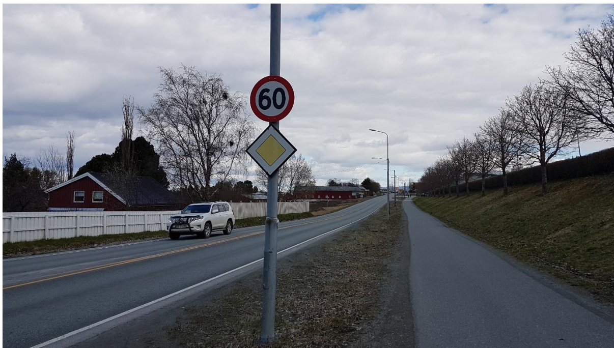
Figur 7: Gang- og sykkelveg langs sørsiden av fv. 950 Malvikvegen ved planområdet
