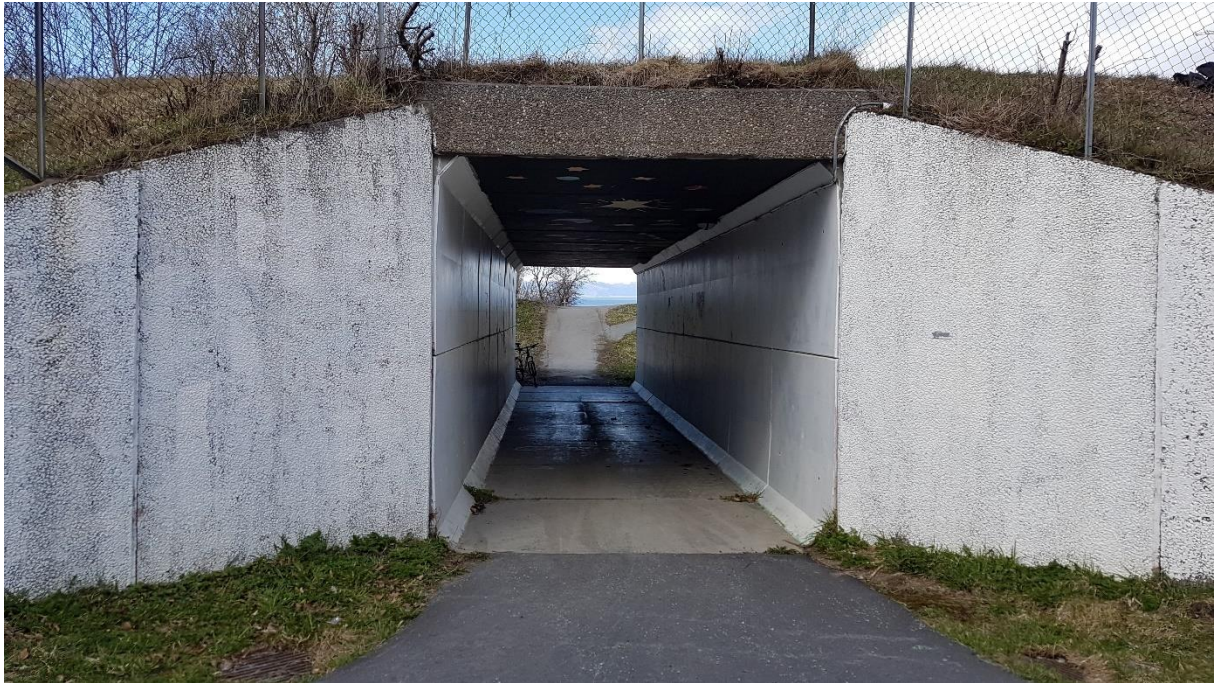
Figur 9: Undergang for gange/sykkel under fv. 950 Malvikvegen ved YMS
