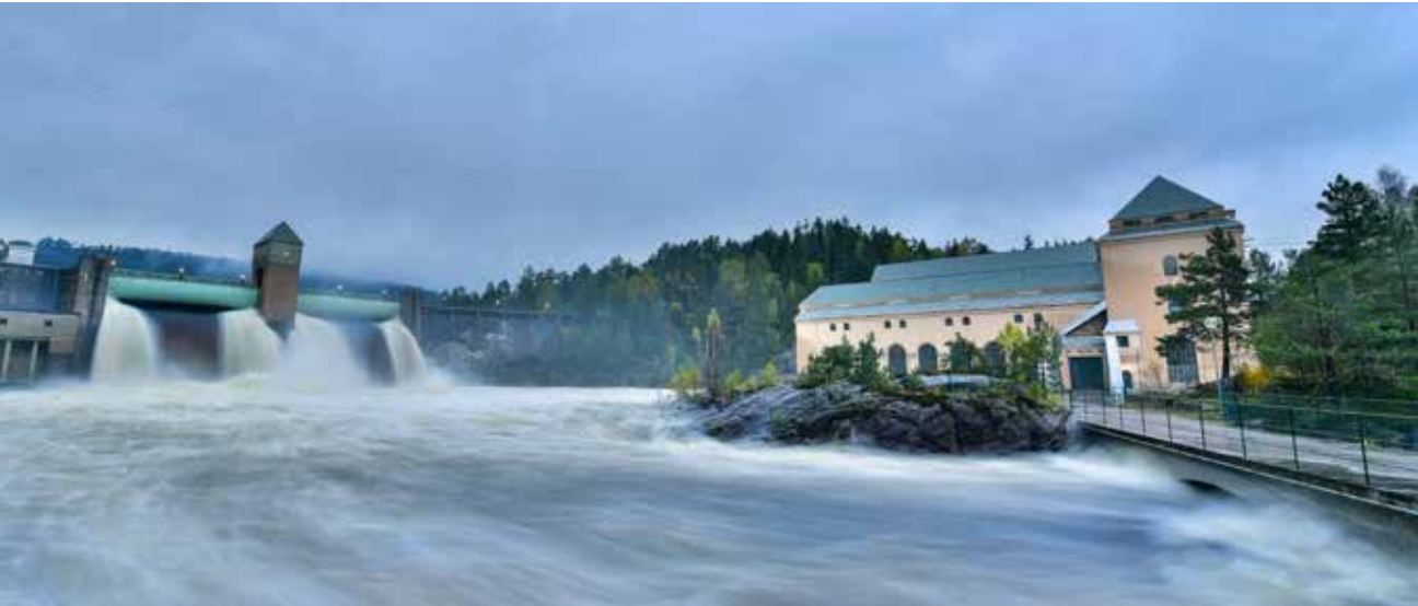
Nomeland kraftstasjon i Iveland. Foto: Geir Daasvatn
