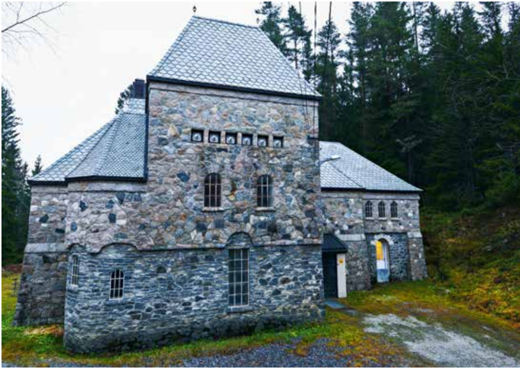
Longerak kraftstasjon, Bygland kommune. Foto: Geir Daasvatn.
