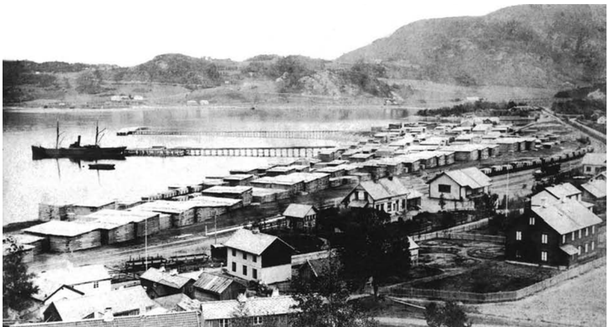
Figur 1 Oversiktsbilde over Hommelvik 1890-1910. Bildet viser trelasttomter på stasjonsområdet (kilde: Norsk Jernbanemuseum) [24]
