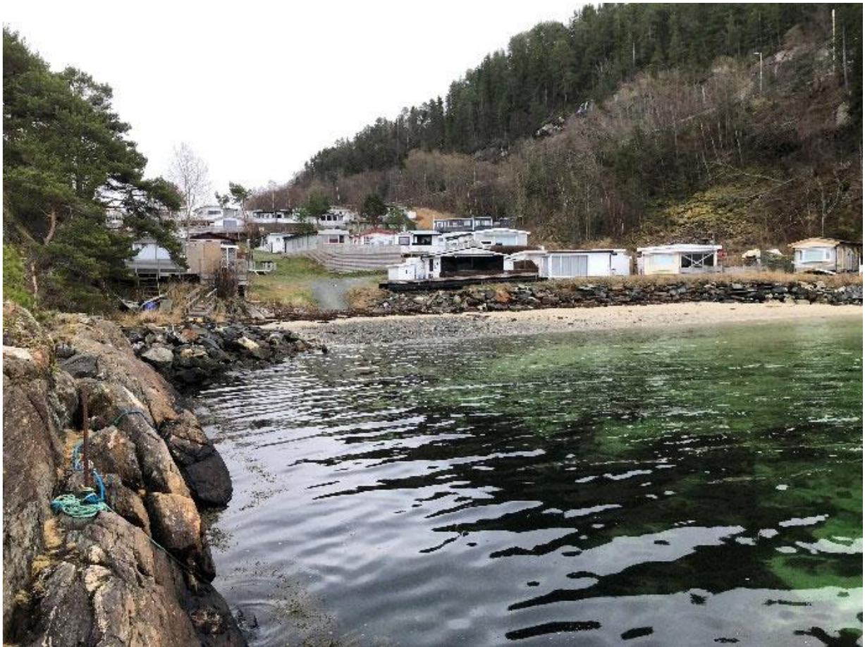
Figur 1-1: Tråsåvika Camping. Kilde: Multiconsult, bilde fra befaring.
