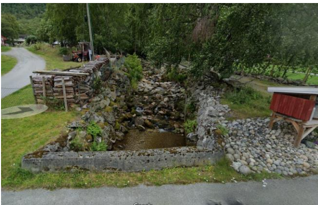
Figur 4-26 Elv i open kulvert gjennom SPB5, sett frå Hagavegen (Google Maps)
